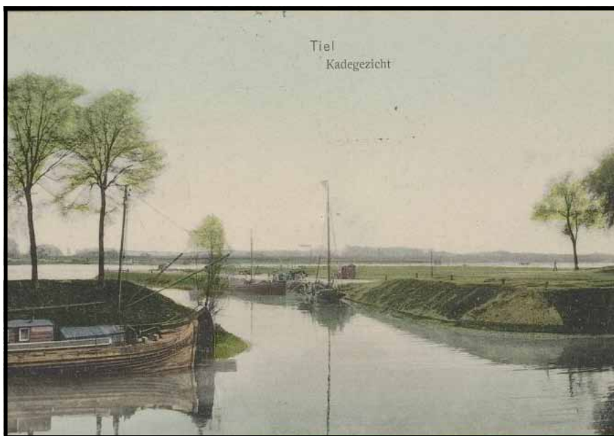
Zicht vanuit de Nieuwe Haven op de Nieuwe Kade (Veerplaat) kort na de realisatie.
